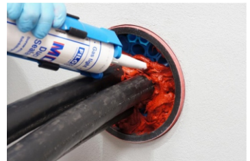
Montaż uszczelnienia przepustu zwykłego FILOseal+HD
